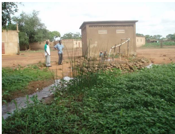
Photo 2: Rejet dans la nature des eaux (potables) du forage artésien de Fon objet d'aucune exploitation
