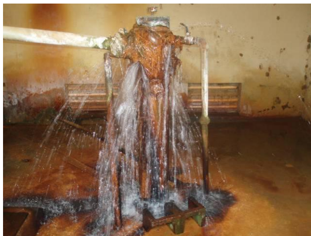
Photo 1: Forage jaillissant de Fon (pression difficile à contenir)
